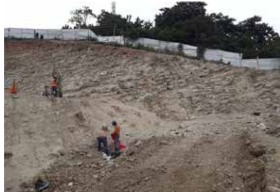
Fotografía 1. Vista del talud de corte para la estación
