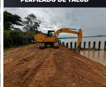
Foto 4. Perfilado del talud
