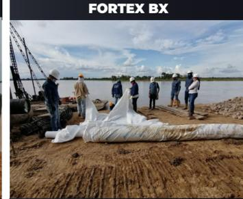
Foto 5. Instalación del geotextil antisocavación sobre el talud
