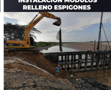
Foto 7. Instalación de los colchones de Geoestera por izaje
