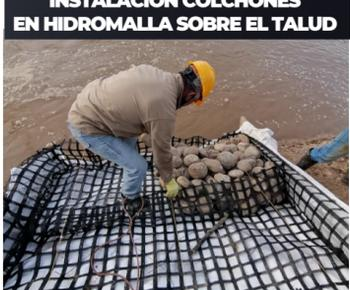
Foto 6. Instalación y llenado de los colchones de Geoestera sobre el talud
