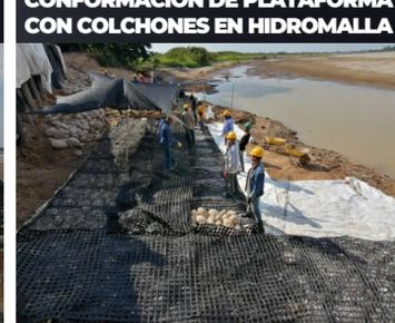
Foto 8. Instalación de geotextil antisocavación y colchones de enrocado confinado con hidromalla Geoestera sobre el talud
