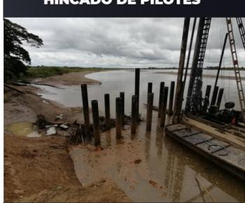
Foto 3. Hincado de los pilotes para el armado de los espigones
