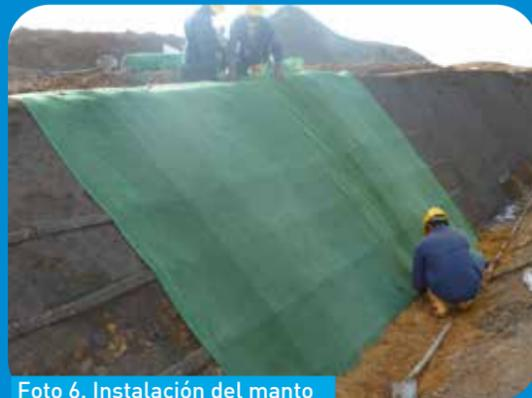
Foto 6. Instalación del manto TERRATRAC® TRM 15
