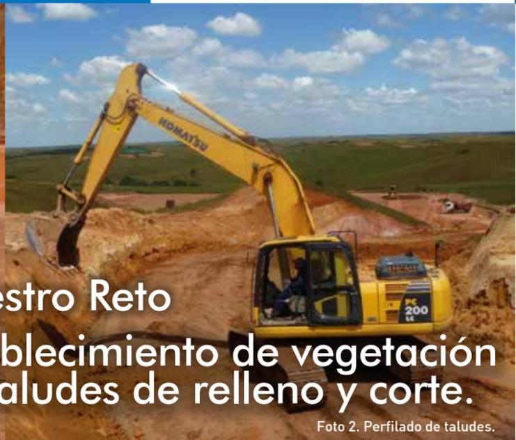
Foto 2. Perfilado de taludes.
