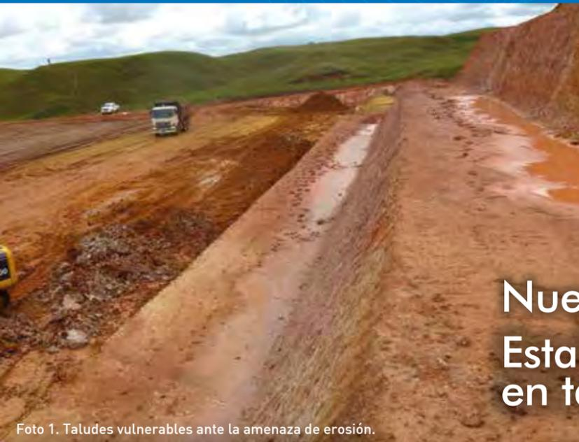
Foto 1. Taludes vulnerables ante la amenaza de erosión.
