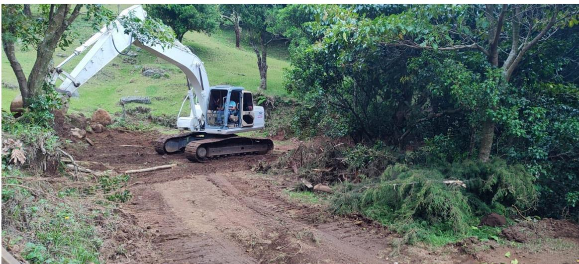
3. Entre las coordenadas CRTM05 462786/1123869 y 462748/1123833 se realizó la apertura de un camino con ancho de 3 metros y 50 metros de largo que invade el área de protección de una naciente tal y como se observa a continuación:
