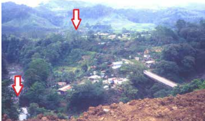
Figura 36. Sitio donde estuvo el albergue de la Dirección Colonial (flecha a la derecha) y punto donde yace el antiguo puente metálico (flecha a la izquierda), más el rellano inmediato, con varias casas. Nótese el puente actual a la derecha, así como los cerros de Izarco al fondo.
